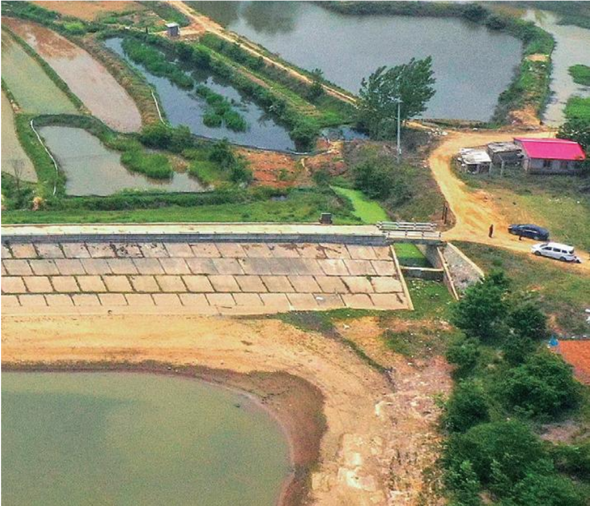
图 1.4-5 孟山坎水库溢洪道
