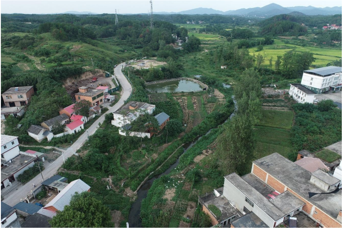
图 4.1.2-3 金刚台镇街区下游附近河道岸带植被航拍
