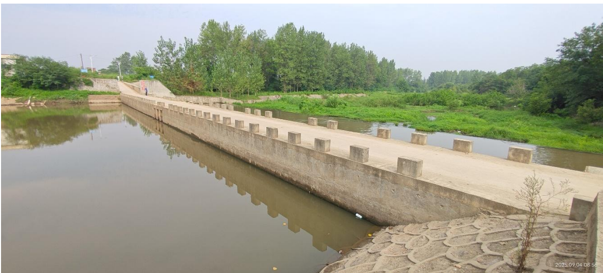
图 4.1.1-14 李老塆漫水桥与溢流堰
