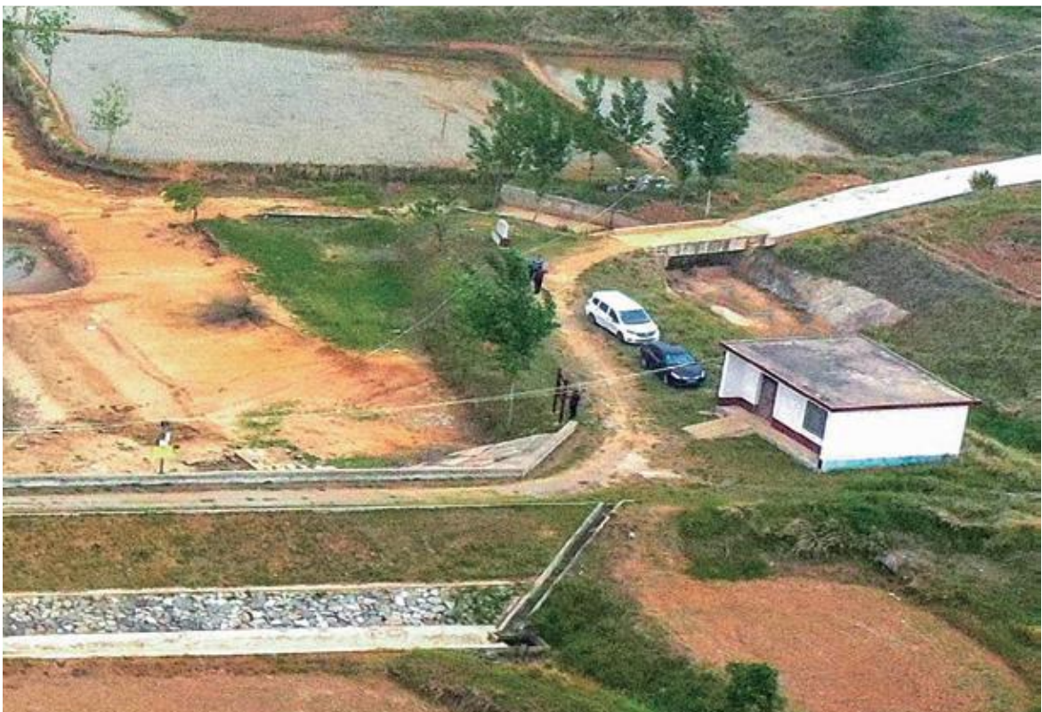
图 1.4-8 紫树埂水库溢洪道和管理房
