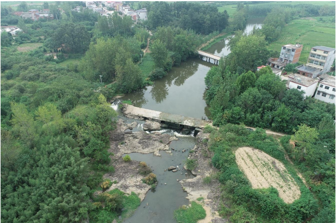
图 4.1.2-14 石梁堰桥附近河道岸带植被航拍
