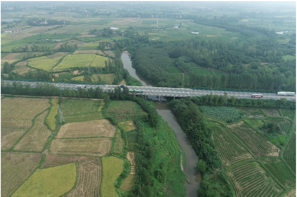
图 4.1.2-12 沪陕高速附近河道岸带植被航拍
