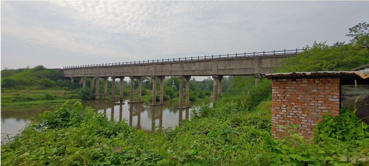
图 4.1.1-18 梅山南干渠渡槽
