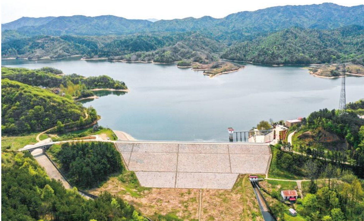
图1.1-6 大石桥水库大坝
