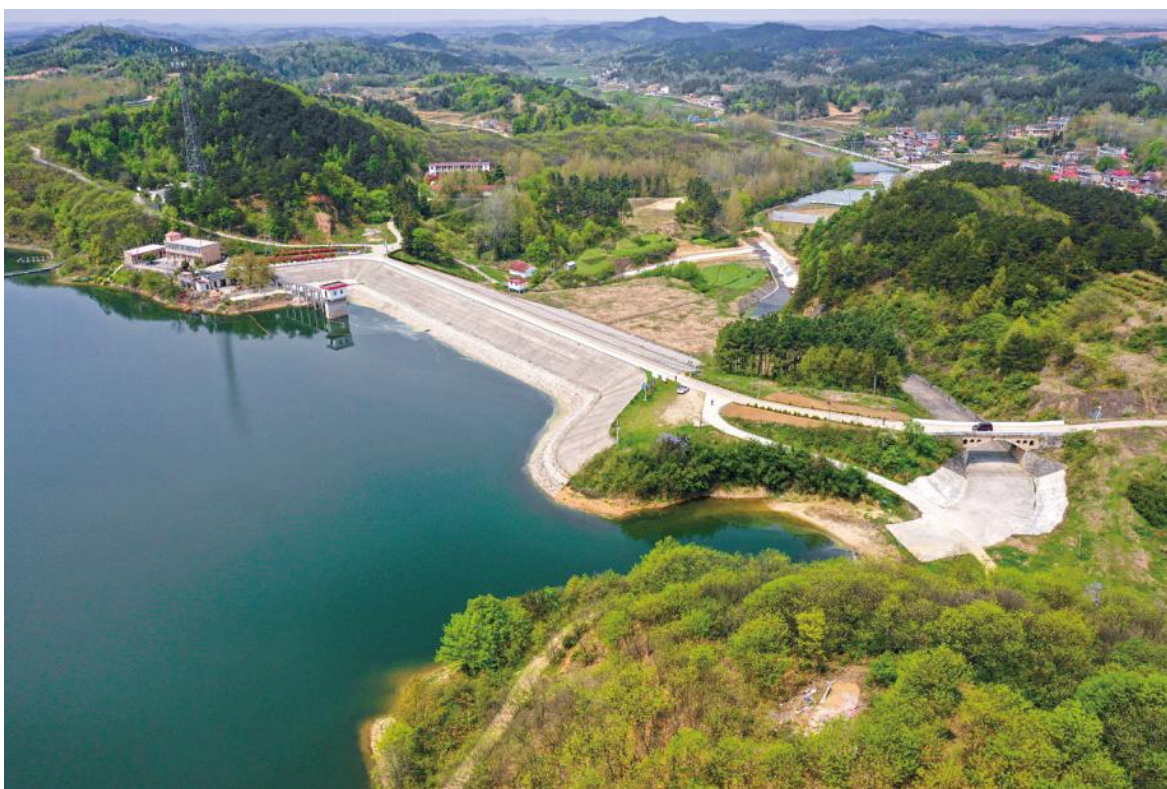
图1.1-7 大石桥水库库周
