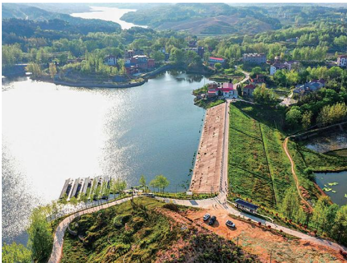
图1.1-10 鲍楼水库大坝
